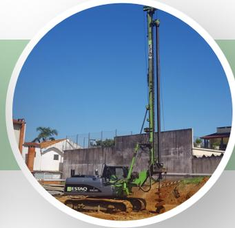
Perfuratrizes para execução de estacas escavadas com até 25m de profundidade e 150cm de diâmetro.
